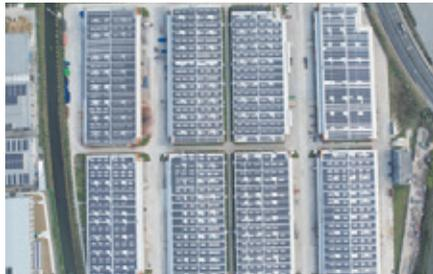
丰树(慈溪)产业园屋顶安装的13.8MWp分布式光伏已于2023年3月并网发电。
